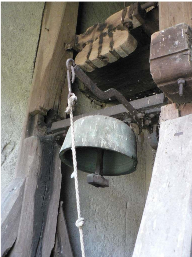
Cimbál osazený jako zvoněk ve zvonové stolici
