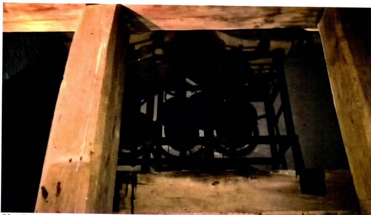
Obr. Severovýchodní strana hodinového stroje – od stěny věže do cca 1/2 věžního prostoru
