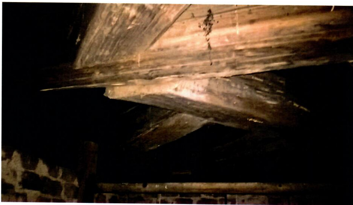
Obr. Dřevěná trámová konstrukce kopule věže nad křížovým (středovým) trámem, na kterém jsou umístěny rozvody k ciferníkům
