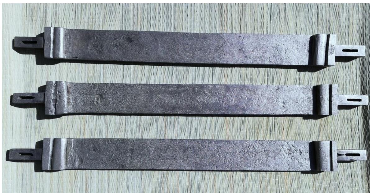
Stav dílů rámu po odstranění koroze
