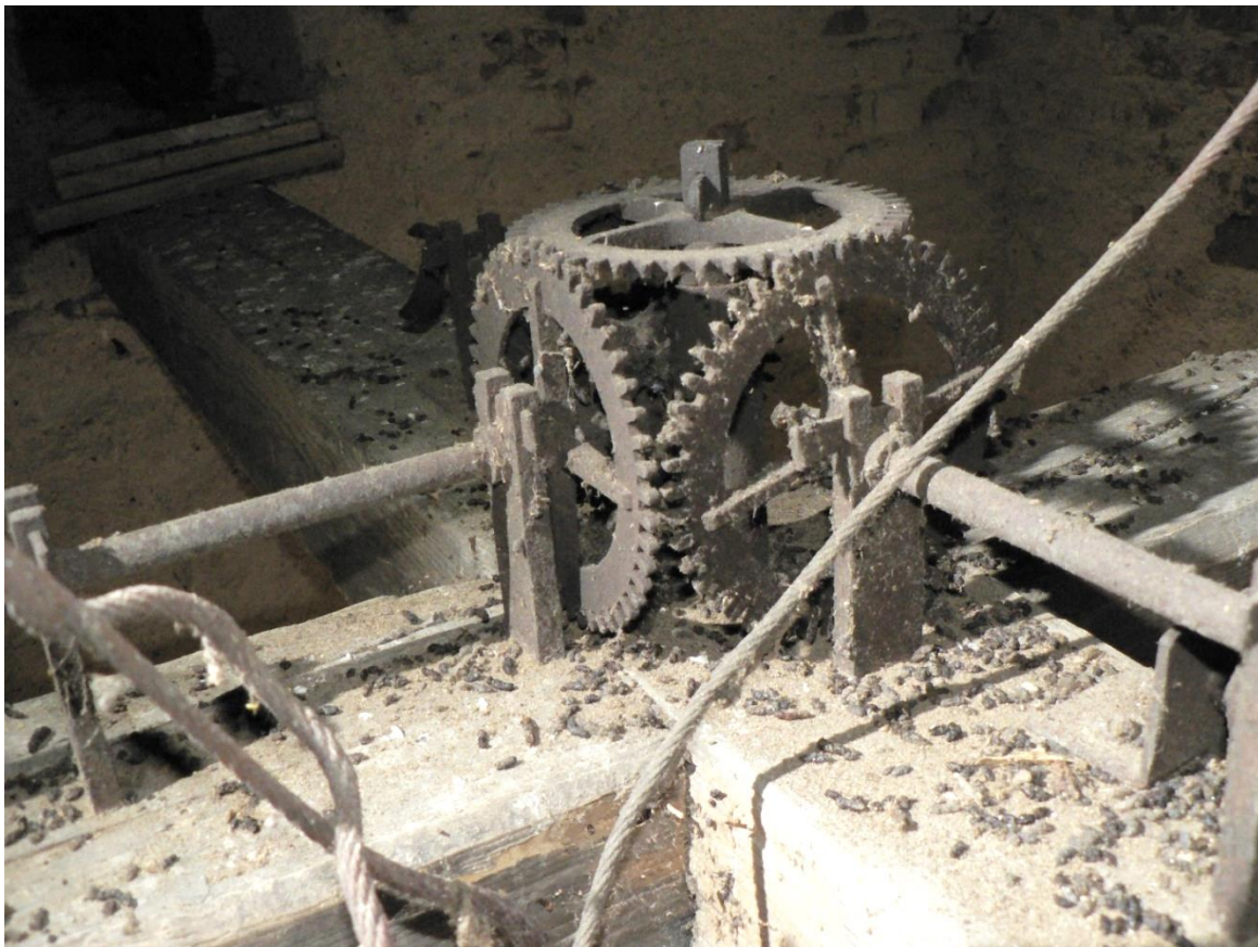
Strojek rozvodu točivého momentu, původní stav
