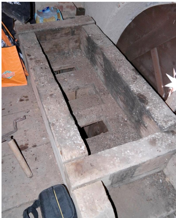
Dřevěný podstavec hodinového stroje po demontáži stroje
